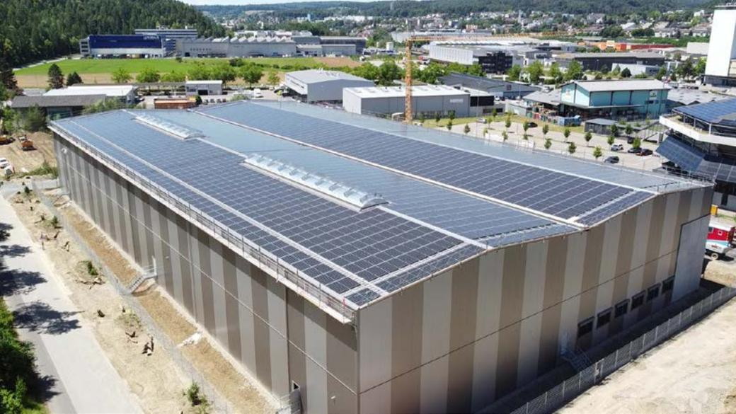
■ Die 2605 PV-Module produzieren 830 Megawattstunden Strom, das reicht für 100 Einfamilienhäuser.
